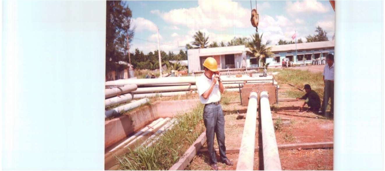
THỬ NGHIỆM TRỤ ĐIỆN TẠI HIỆN TRƯỜNG.
