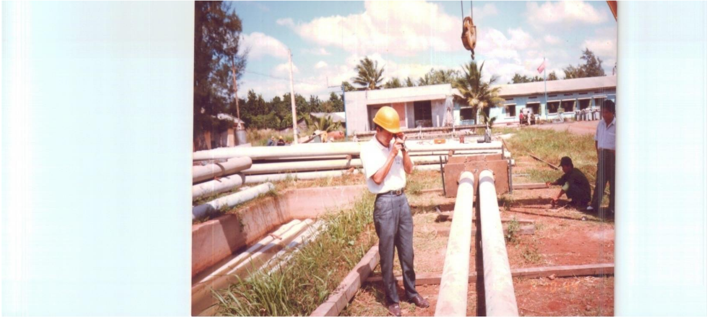
THỬ NGHIỆM TRỤ ĐIỆN TẠI HIỆN TRƯỜNG.
